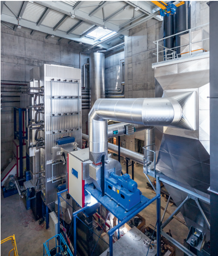
Biomassenzentrale: Thermoöl wird für den Backprozess erhitzt.
