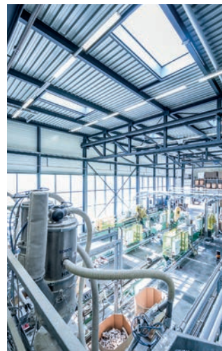
Die hohe Ausbeute an konstantem Tageslicht verteilt sich gleichmässig im Inneren des Gebäudes.
